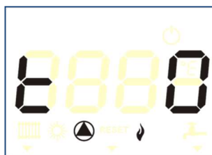
Prevádzka v režime „Kominár“ s maximálnym výkonom
